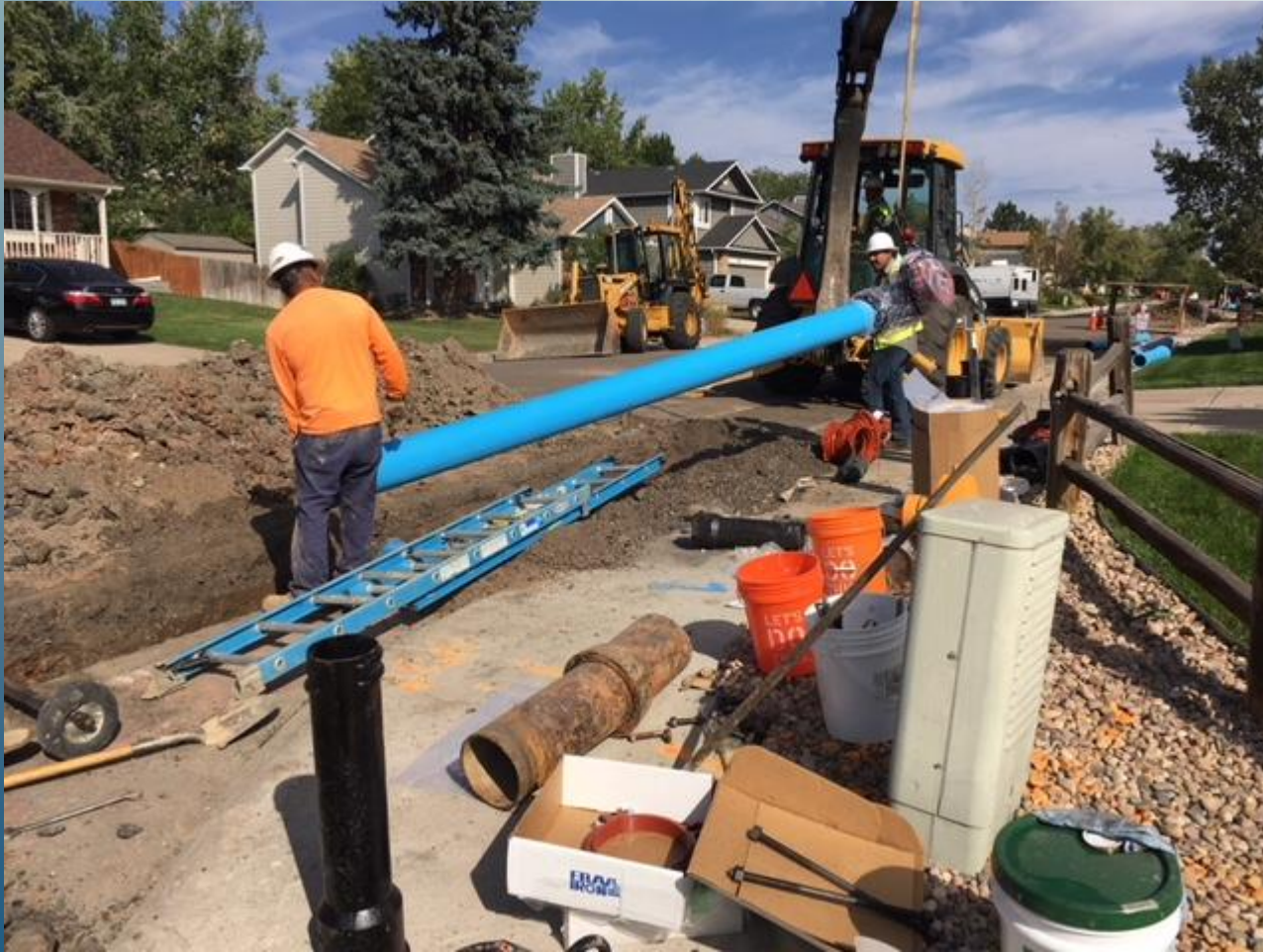
Installing 8” PVC Pipe
